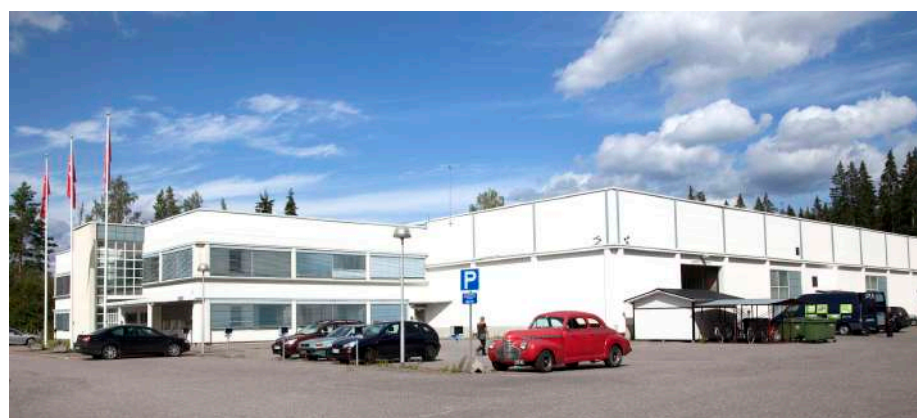
Mittametallin tehdashalli on periaatteessa uutta vastaavassa kunnossa.
